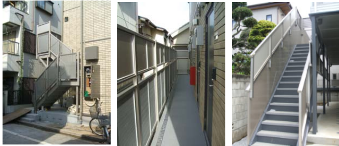
パンチングパネル 折返階段・目線目隠
