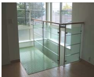
FRP グレーチング床
