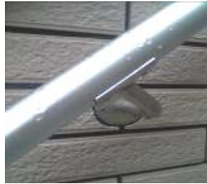
補助手摺(パイプ)
